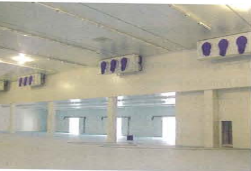
Die vier Verdampfer in der im Bau befindlichen TK-Halle
