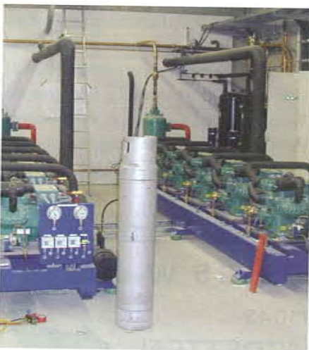
Beim Einbau der Verbundanlagen
