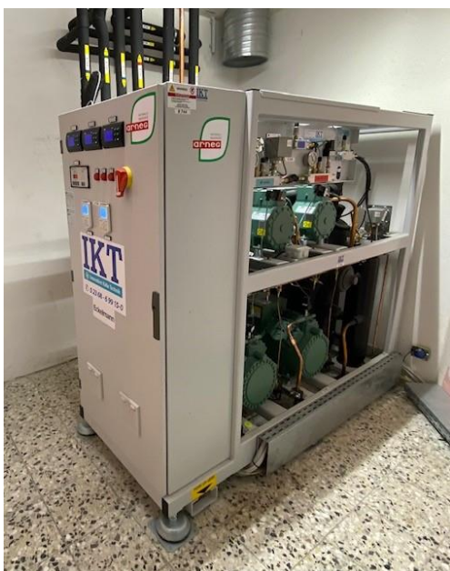
Bild 1: Transkritischer Mini-Booster von Arneg (Foto: IKT / Arneg)
