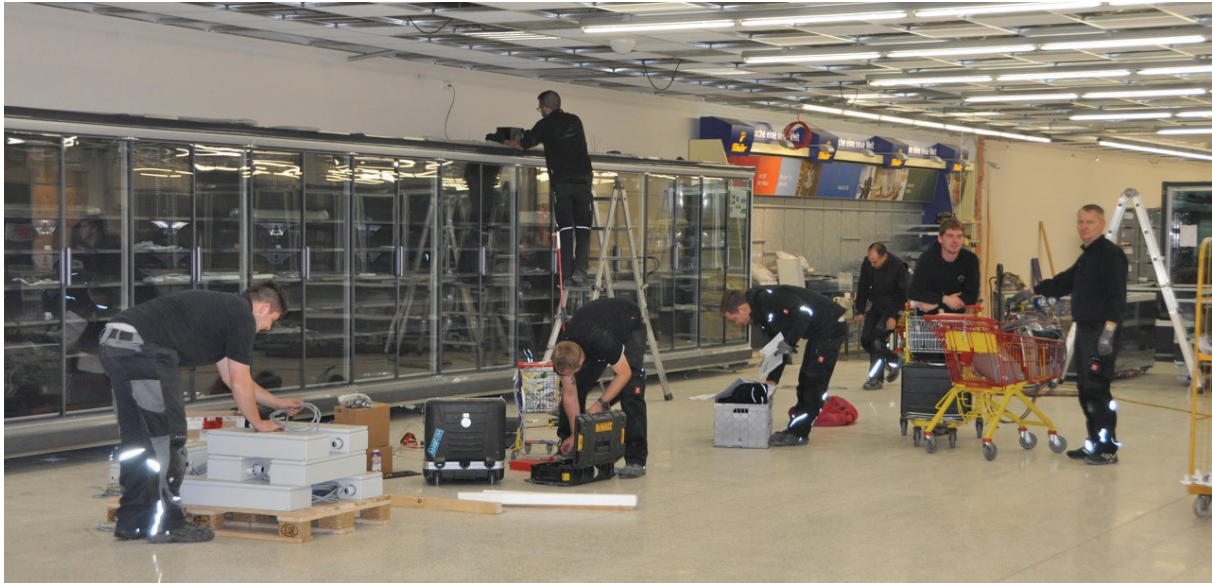
Abb. 1: Mitarbeiter der Firma Meilbeck installieren die neuen Kühlmöbel. (Foto: Meilbeck)
