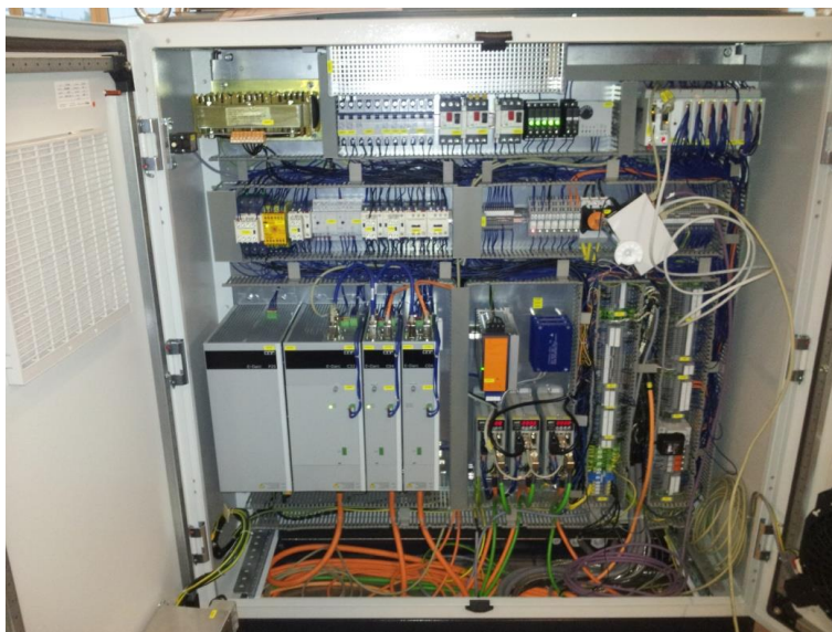
Abb. 4: Kompaktsteuerung E°ENC 66 mit I/O-Modulen und E°Darc Antriebspaket www.ferrocontrol.de
