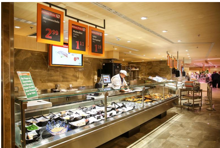
Bild 3: NK-Kühlmöbel mit Isolierglastüren (Foto: Globus SB-Warenhaus)
