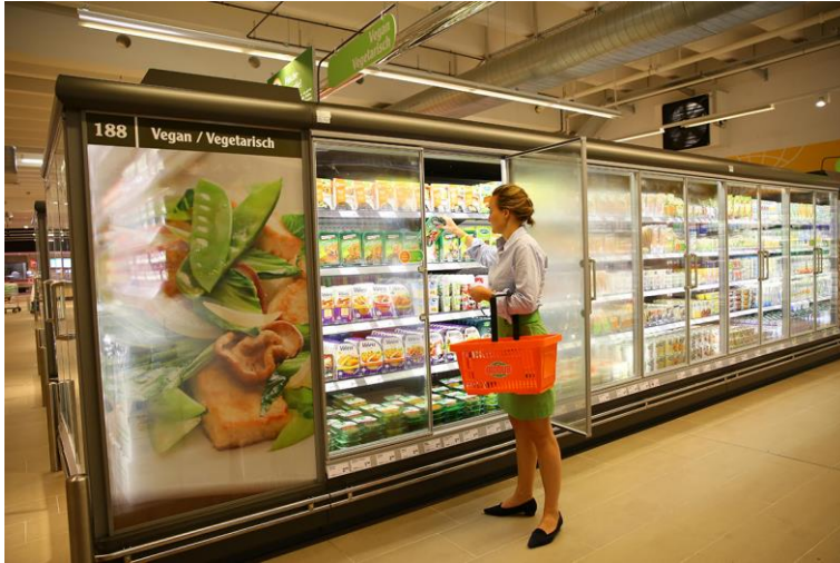
Bild 2: NK-Kühlmöbel mit Isolierglastüren (Foto: Globus SB-Warenhaus)
